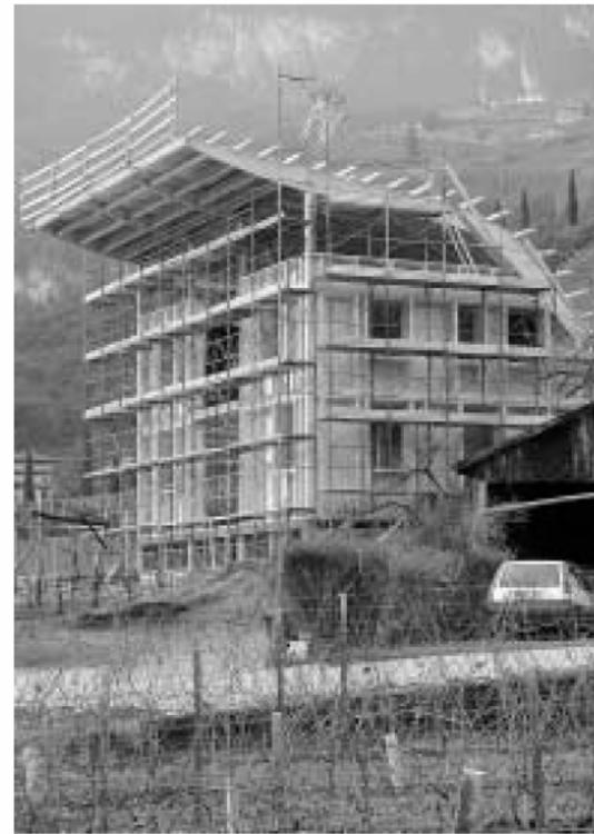
ausstrocknen können, z. B. sollten Vordächer nicht zu klein und nicht zu groß sein, je nach Lage und Klima. Nach meiner Ansicht müssen Strohballenwände als dampfdurchgängige Konstruktionen realisiert werden. Eine Dampfsperre auf der Innenseite ist im Winter in Ordnung, im Sommer jedoch auf der falschen Seite und umgekehrt.
