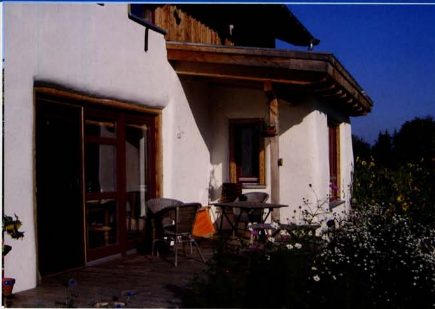
◀ Bei Strohballenbauten mit Aussenputz sind die abgerundeten Gebäudekanten ein typisches Merkmal.
