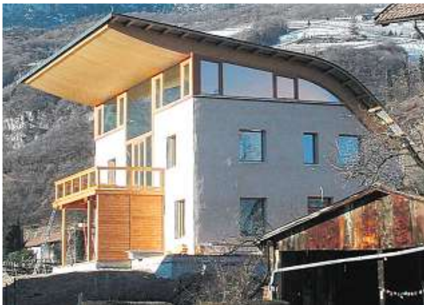
Beschwingt: In Kurtatsch (Südtirol) steht dieses Strohballenhaus, das Schmidt mit einer einheimischen Architektin geplant hat.
