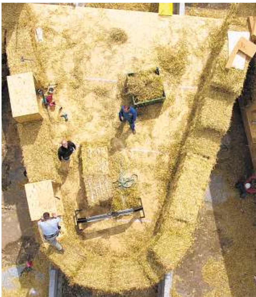
Vor Ort: Der Architekt hilft mit, wem – wie hier beim Ferienwohnungsbau in V-Form in Lana bei Meran – ums Ballenstapeln geht.
